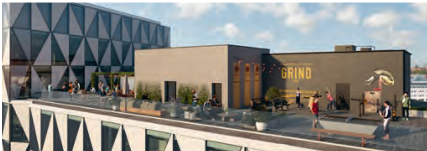
Kontorshuset Prisma i Oceanhamnen är Helsingborgs nya landmärke. Huset har en takterrass med utomhusgym, arbetsplatser och plats för umgänge.
