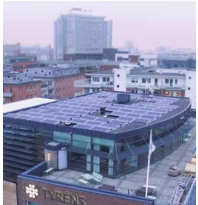
I samband med om- och tillbyggnaden av Tyréns lokaler i Malmö installerade vi 154 solcellspaneler på taket.
