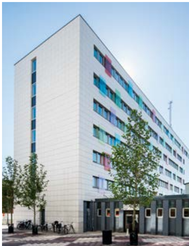
I Polisen 6 i Helsingborg finns hyresgäster som Skatteverket, Kronofogdemyndigheten och Försäkringskassan.
