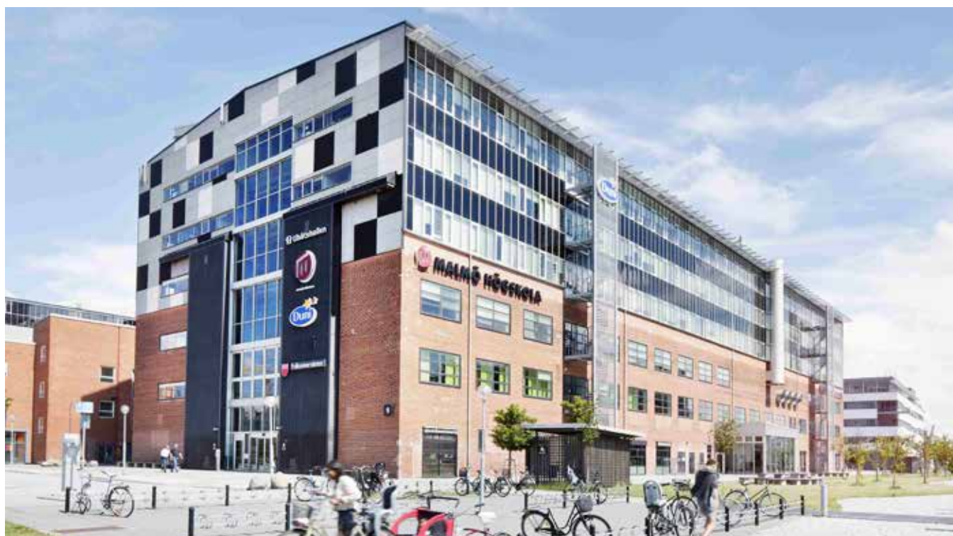
Ubåtshallen i Dockan byggs om för Försäkringskassan som tecknat hyresavtal för 12 300 m 2 . Här har under ett flertal år bedrivits skolverksamhet – både Malmö Högskola och Mediegymsnasiet har haft utbildningar här. Nu ska fastighetens fem nedersta våningar förändras till rena kontorsytor. Den sjätte och översta våningen hyrs av Duni.
