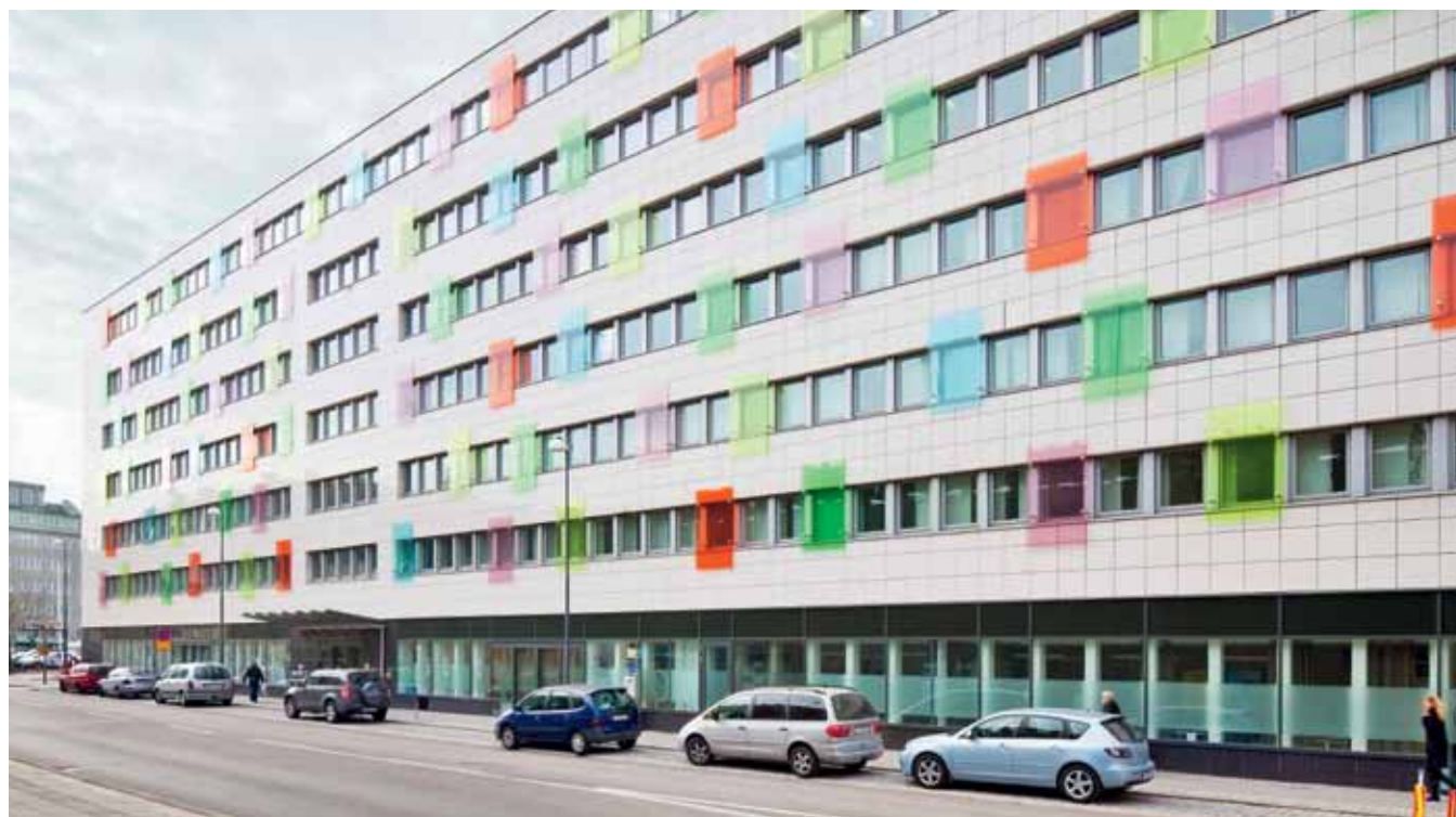
Fastigheten Polisen 3 i Helsingborg var en av vinnarna av Sweden Green Building Awards 2012. Byggnaden använder idag ca 50 % mindre energi än före ombyggnaden.
