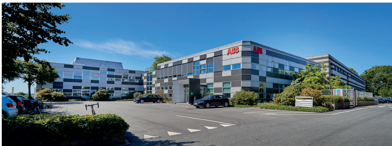
Meterbuen 27–33 i Ballerup, Köpenhamn, är ett av de förvärv som gjorts i Köpenhamn under året vilket tillförde ytterligare drygt 17 000 m 2 till Wihlborgs danska bestånd.
