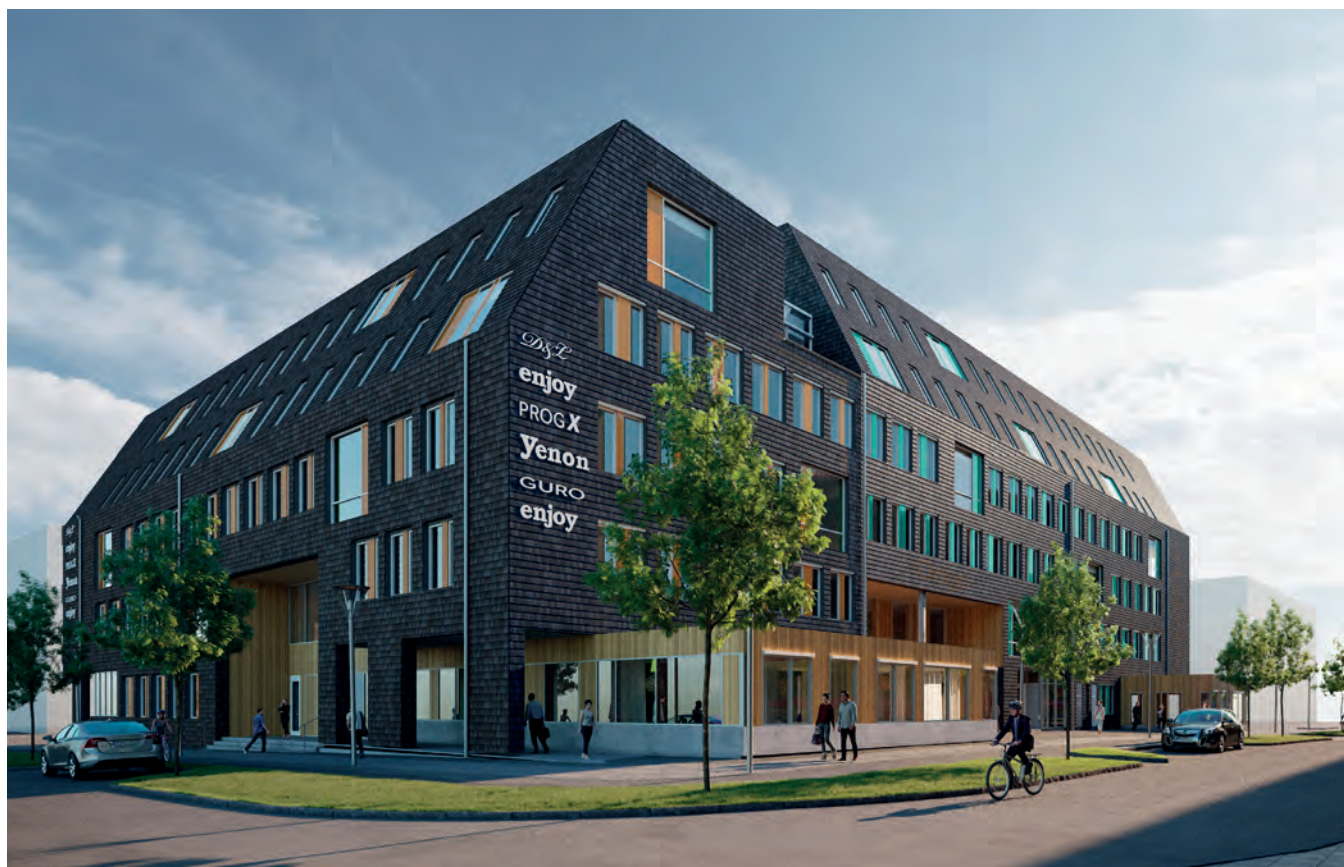
I Hyllie bygger Wihlborgs kontorshuset Origo med inflyttning sommaren 2019. Alla hyresgäster får egen balkong och i huset finns gemensamma konferensrum och cykelgarage med dusch och omklädningsrum. Byggnaden kommer att certifieras enligt Miljöbyggnad Guld.
