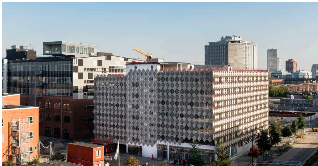
I Wihlborgs nya parkeringshus Ubåten (Hordaland 1) på Dockan Malmö, kan man ladda elbilen med solenergi.
