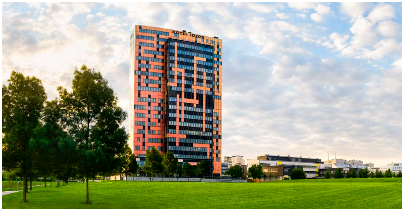
Ideon Gateway i Lund är ett av Wihlborgs mest miljövänliga hus. En stor del av fasaden är täckt med solpaneler och huset har fått miljöcertifieringarna; Miljöbyggnad Guld och LEED Platina.
