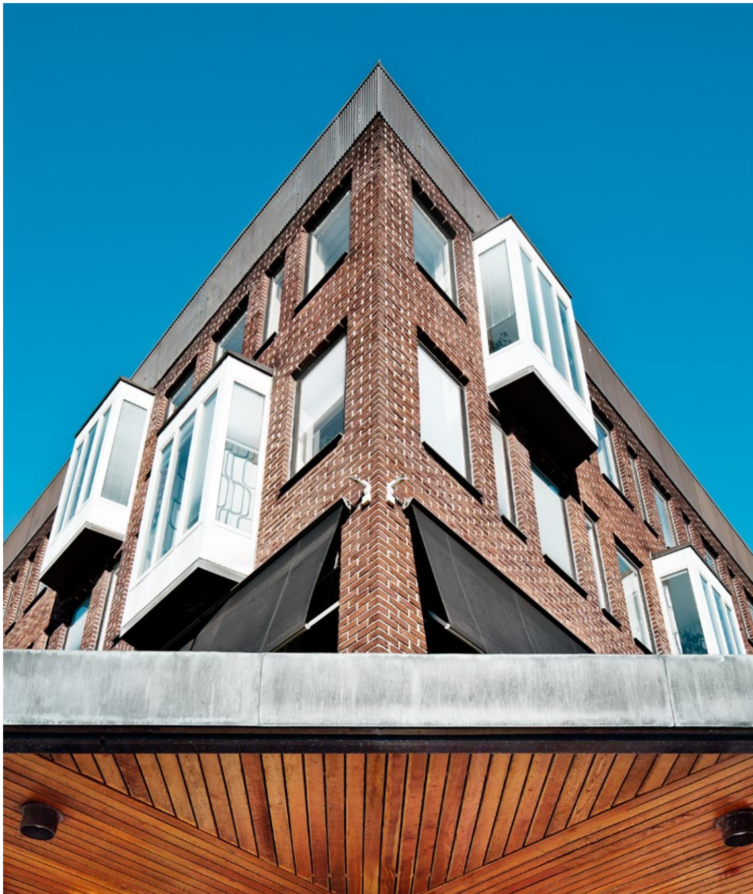
Fastigheten Bytarebacken 39 ligger mitt emot Lunds centralstation. Här slutfördes en utvärdig renovering av tak, fasader och sockel samt fönsterbyte.
