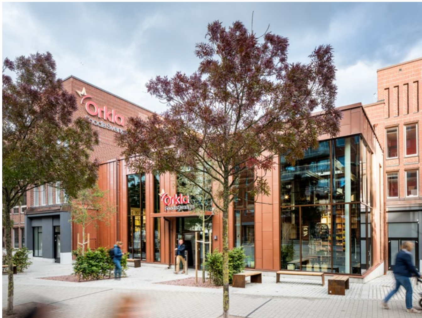
Kranen 1 i Dockan har genomgått en omfattande om- och tillbyggnad för Orkla Foods Sverige som våren 2016 flyttade huvudkontoret från Eslöv till Malmö.
