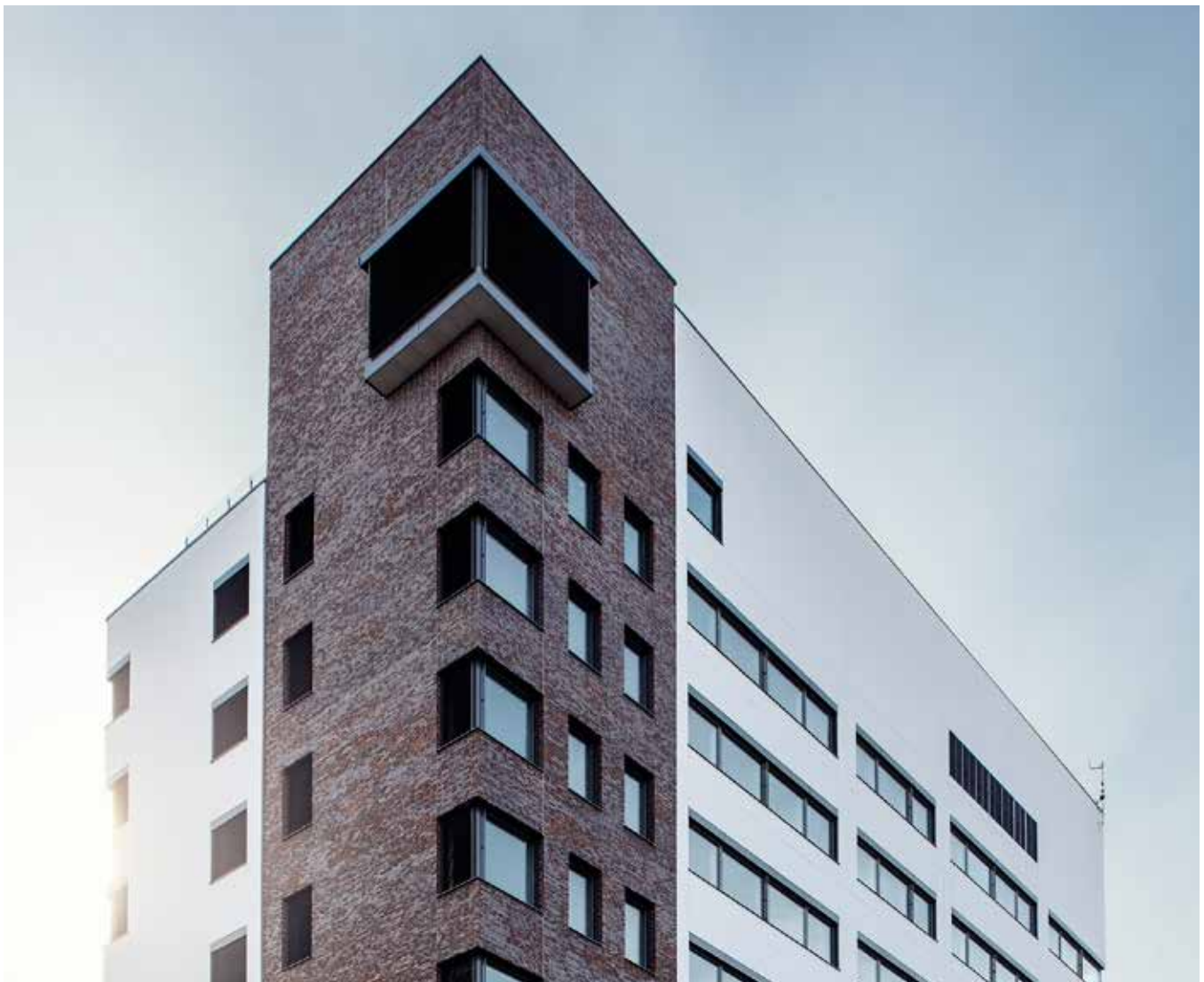
Från maj till december 2015 har Florettens solceller på taket producerat ca 37 000 kWh.
