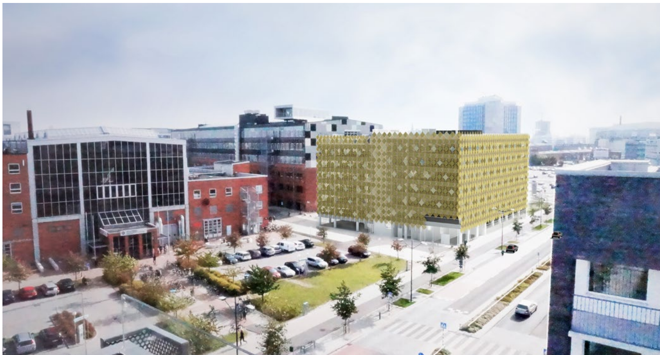
Låt oss presentera Hordaland 1, det nya parkeringshuset på Dockan, Malmö. Det 15 000 m 2 stora parkeringshuset kommer stå färdigt under hösten 2017.
