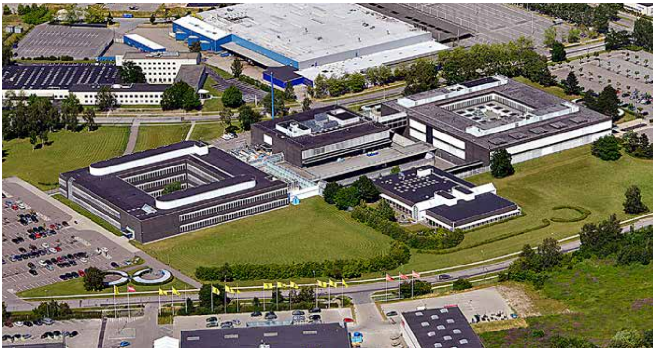
Wihlborgs största förvärv i Danmark innefattar fastigheten Ejby Industrivej 41 i Glostrup.
