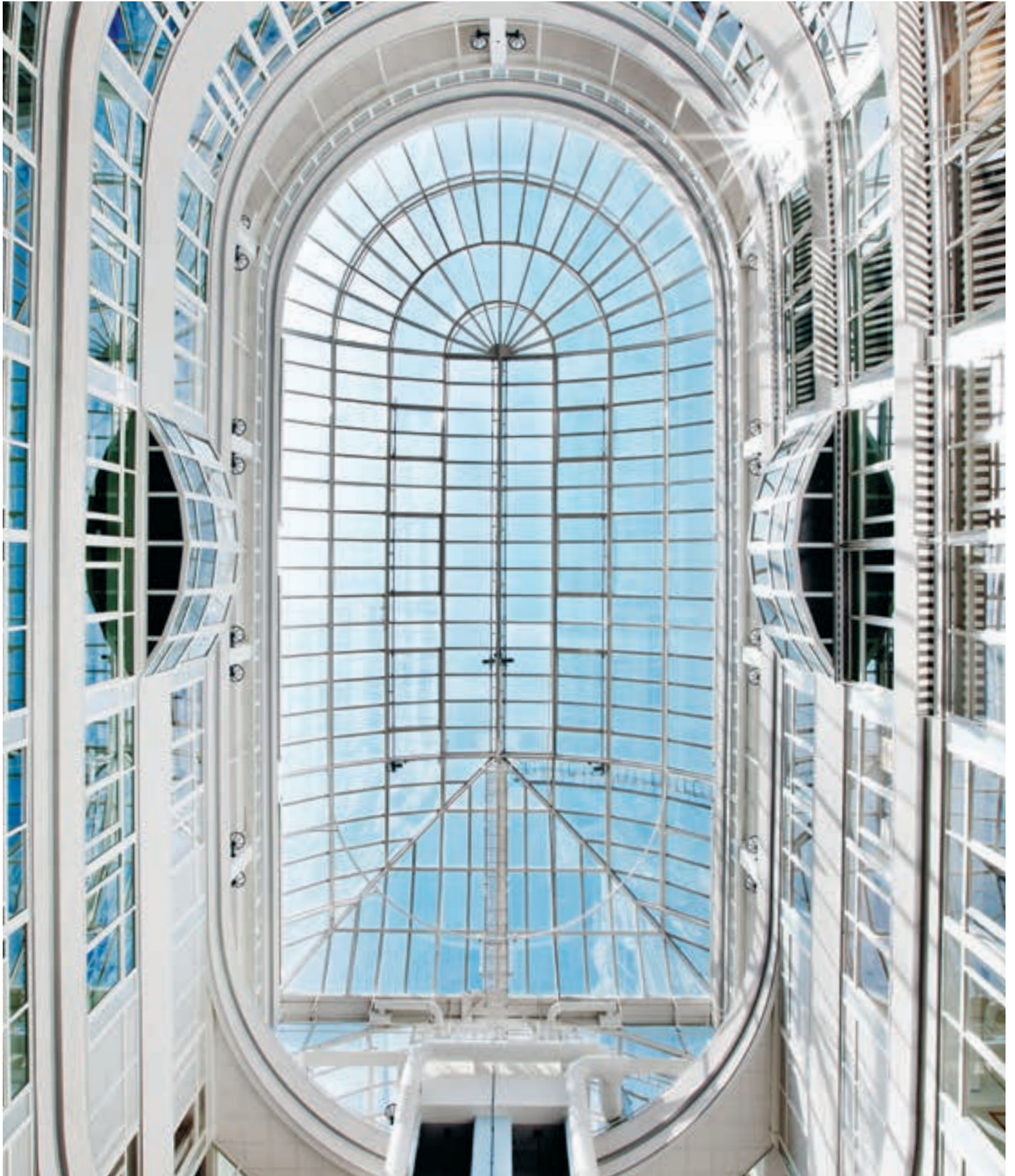
Fastigheten Elefanten 40, mitt i centrala Malmö, med sitt vackra glastak.
