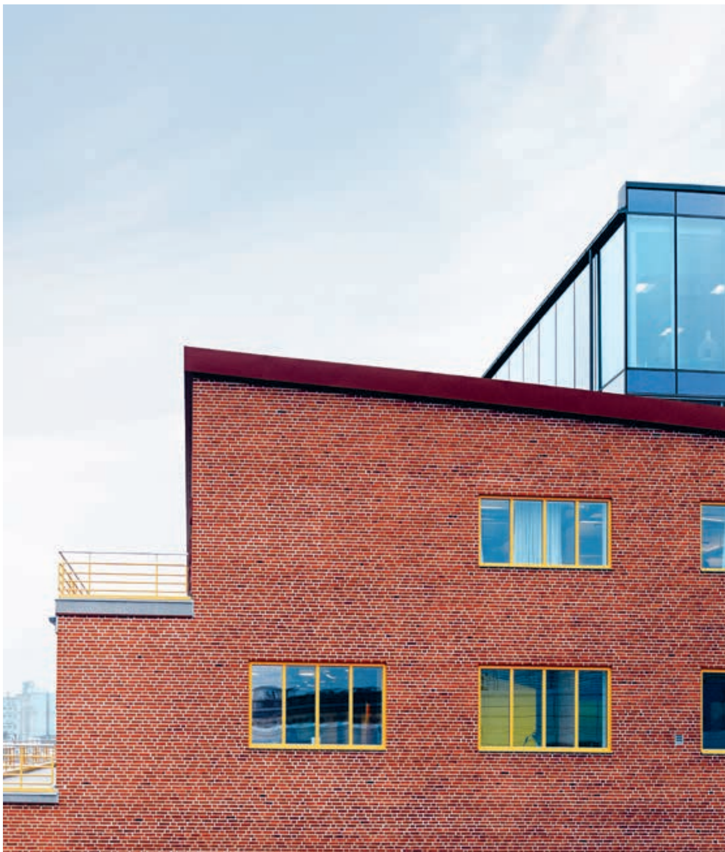
Projektet Magasinet vid Stockholmskajen färdigställdes 2012.
