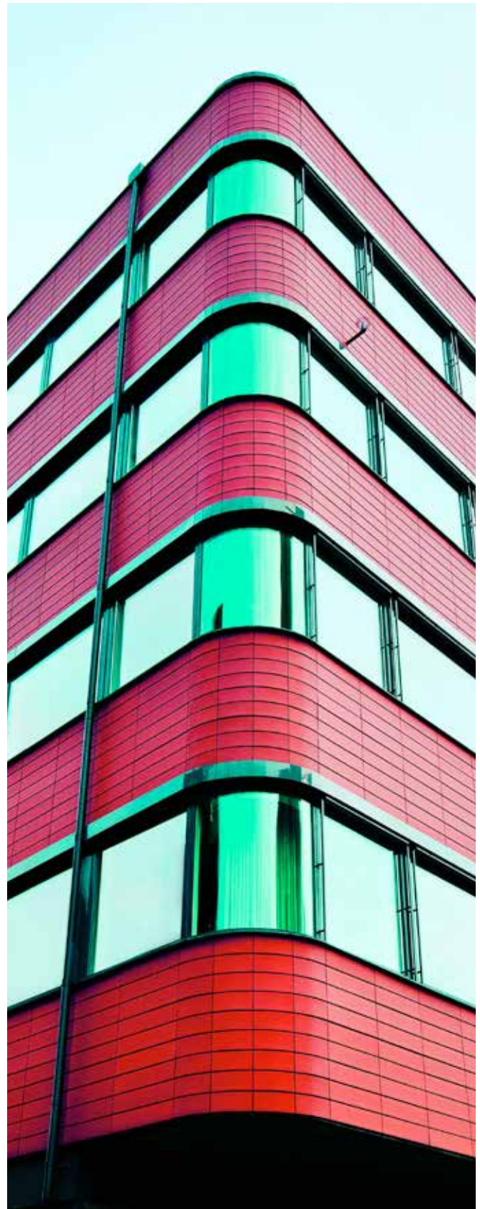
Skrovet 5 på Dockan erbjuder totalt 8 700 m 2 kontor och butikslokaler.
