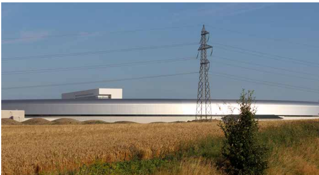
Bygget av forskningsanläggningen MAX IV påbörjades 2010 och är nu inne i slutskedet. I augusti tilldelades fastigheten betyget Guld i Miljöbyggnad. Anläggningen ska vara färdig andra kvartalet 2015.
