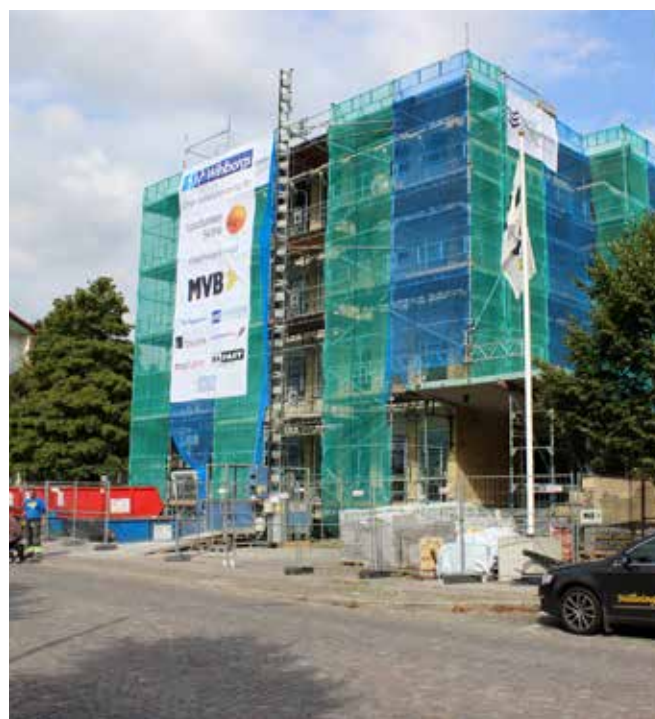
Wihlborgs bygger om fastigheten Landstinget 2 i Lund för Sparbanken Skånes räkning. Projektet ska vara färdigt 1 januari 2015.
