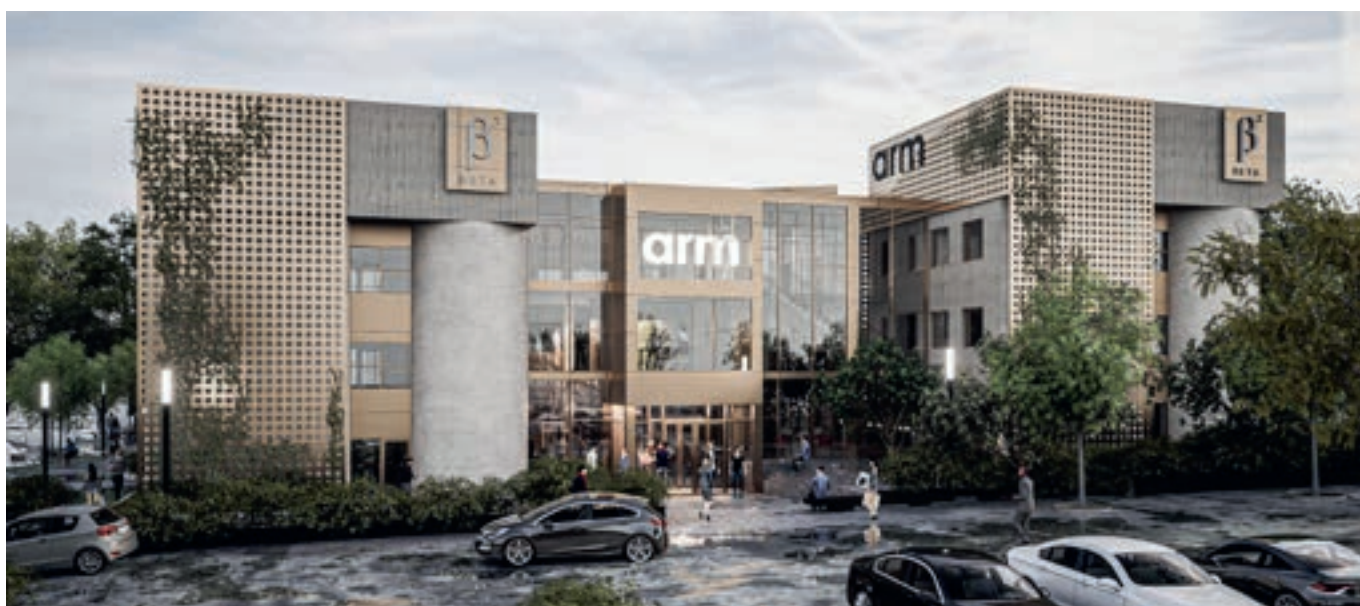
I Lund genomför vi en om- och tillbyggnad av byggnaderna Beta 1 och 2 (Vätet 1) för chipdesignbolaget Arm. I syfte att minska klimatpåverkan behålls den befintliga stommen och tekniska installationer uppraderas.
