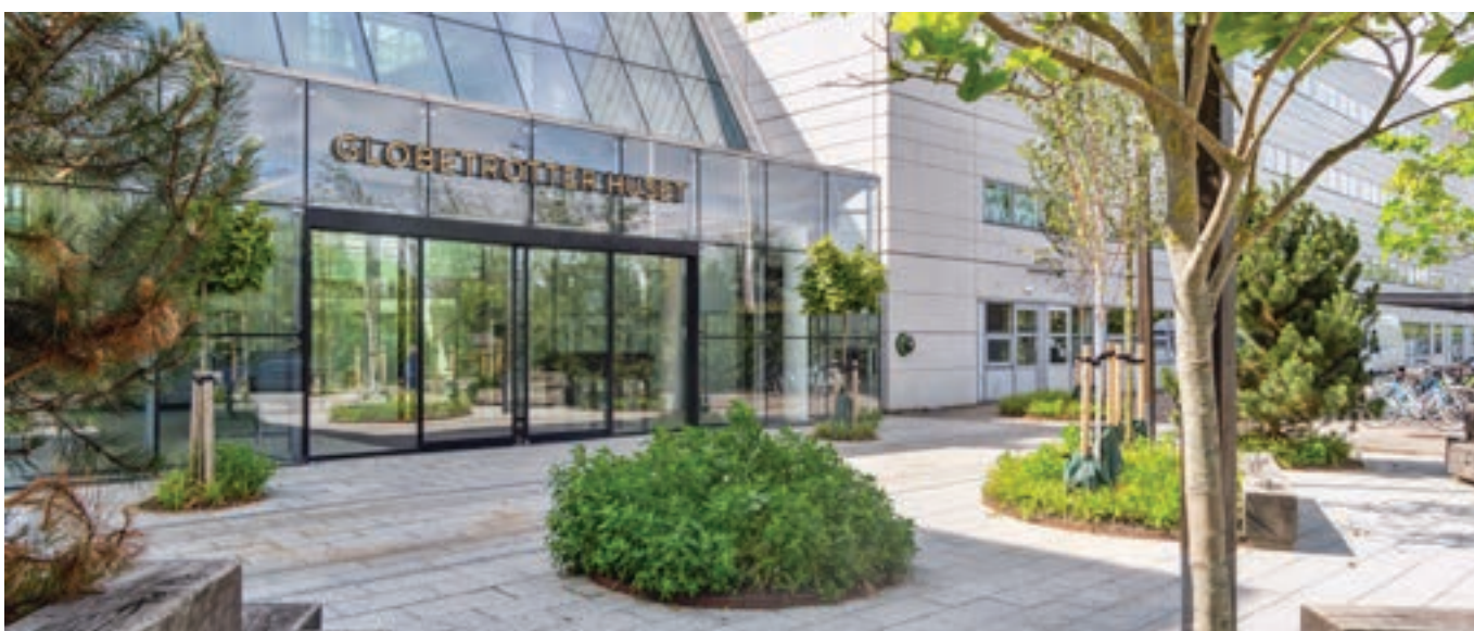
Hedegaardsvej 88 på Amager har genomgått en omfattande renovering i syfte att få till flexibla och moderna lokaler i varierande storlekar som matchar efterfrågan på marknaden. Under processens gång fick huset namnet "Globetrotterhuset".
