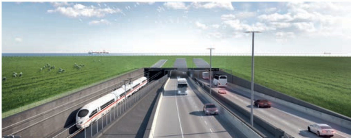
I november 2021 togs det första spadtaget på tysk mark för Fehmarn Bält-tunneln som väntas vara färdig 2029. Bild: Femern A/S
