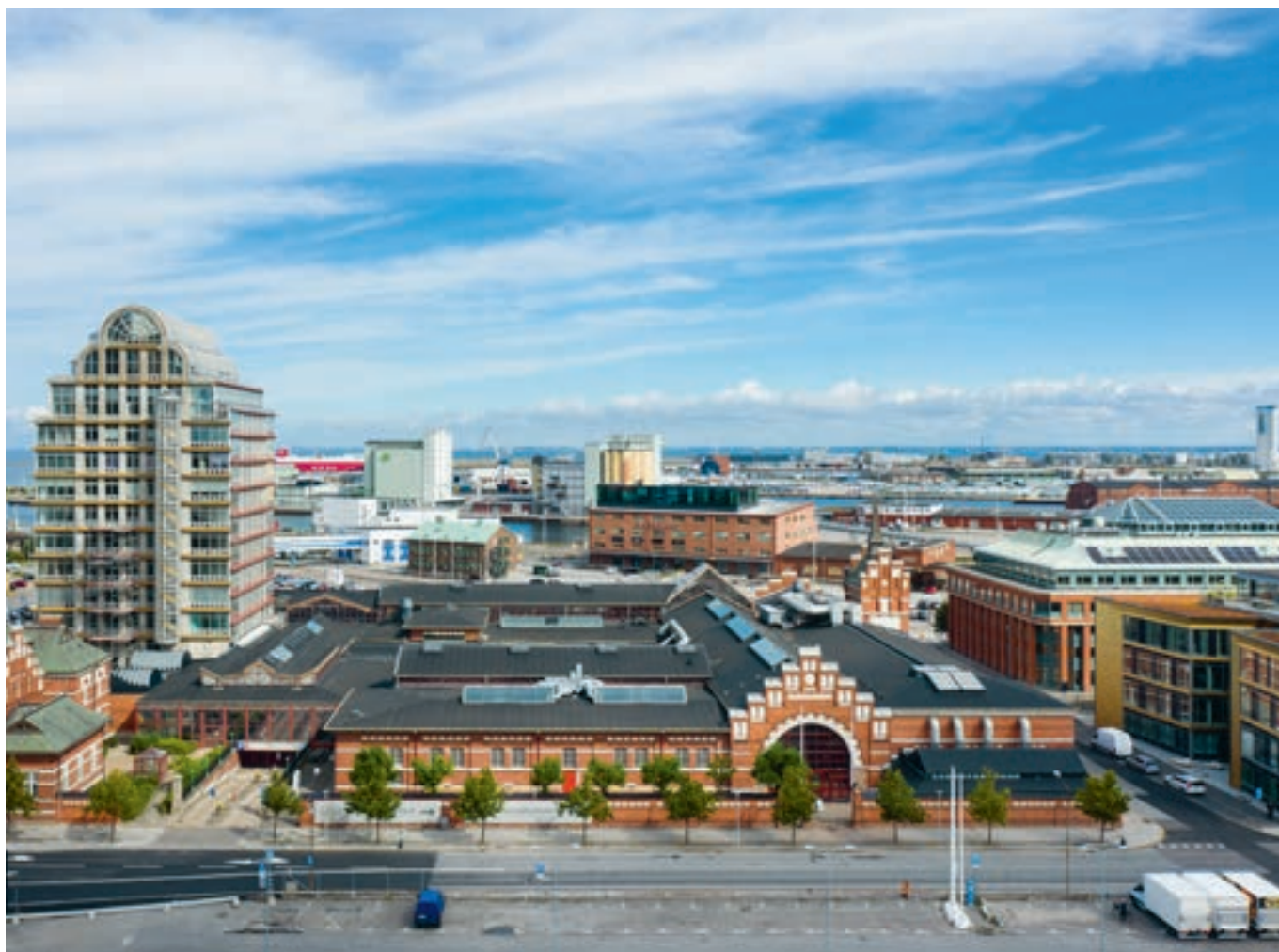
I Nyhamnen har vi flera fastigheter på strategiska lägen. I förgrunden syns Slagthuset 1. Till höger i bild skymtas Sirius 3 och bakom Slagthuset 1 syns Hamnen 22:188 (Magasinet).
