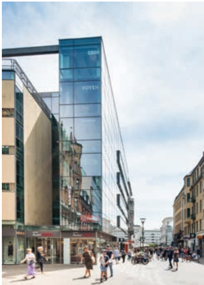
S:t Jörgen 21 i centrala Malmö har fått solceller.
